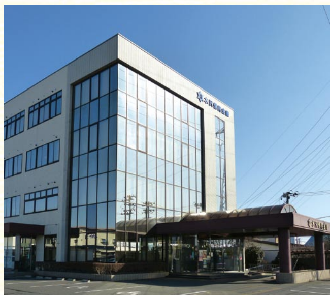
水沢信用金庫 本店外観
