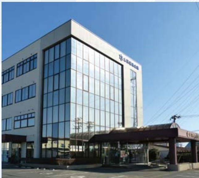
水沢信用金庫 本店外観
