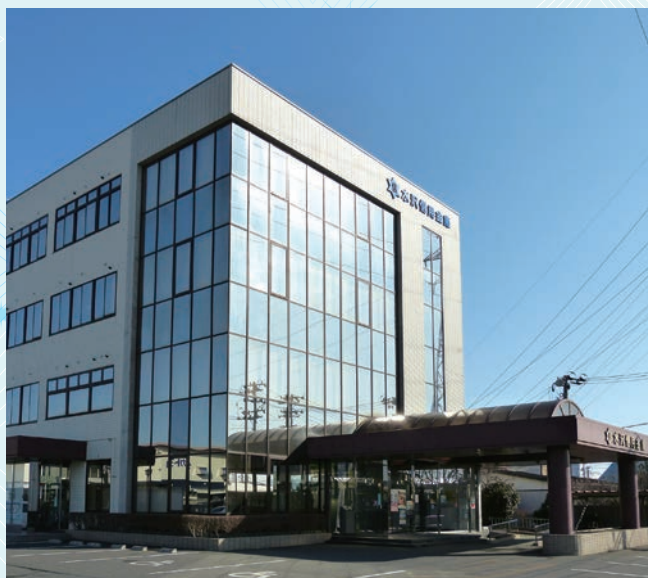
水沢信用金庫 本店外観
