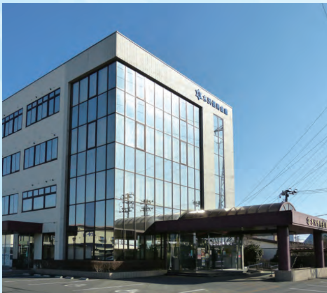
水沢信用金庫 本店外観
